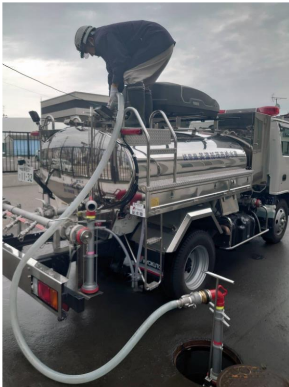
能町ポンプ場 消火栓からの注水状況
