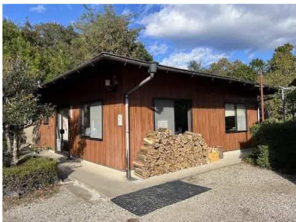
③ 作業員休憩所
