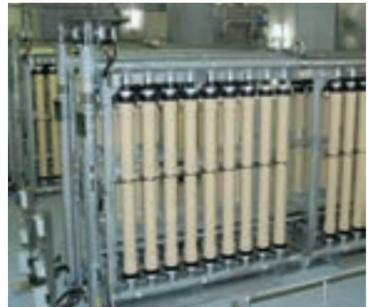
▲膜ろ過処理装置。耐塩素性病原生物を完全除去します
