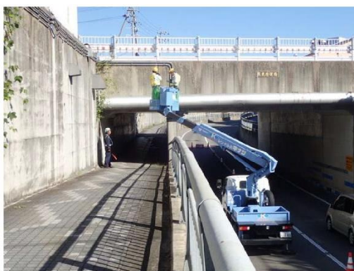
写真-1.1 専門業者による点検状況①
