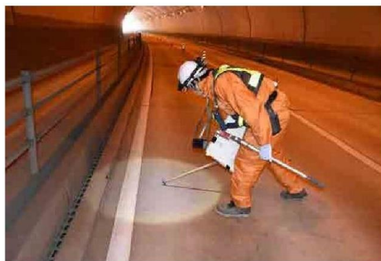
写真-1.1 専門業者による点検状況①
