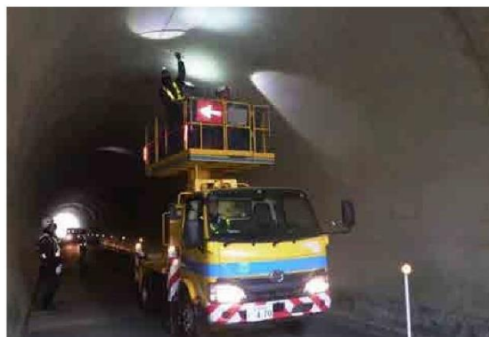
写真-1.2 専門業者による点検状況②
