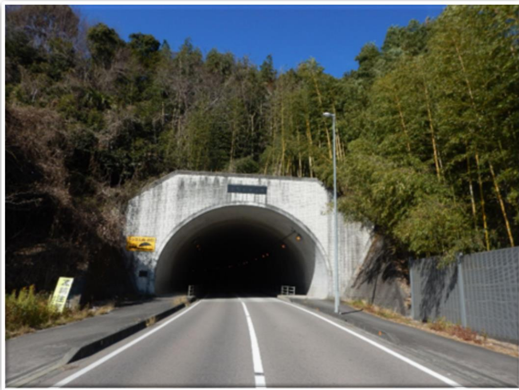
上野トンネル
