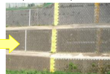
量水標(H23修繕後)視認性の向上
