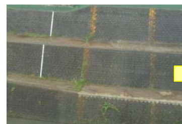
量水標(修繕前)
