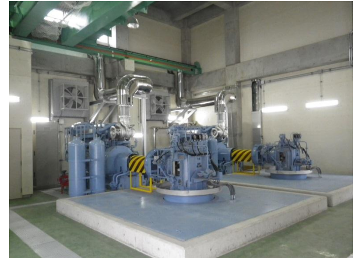
増設したポンプ
