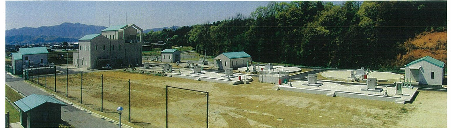
水処理汚水処理施設全景
