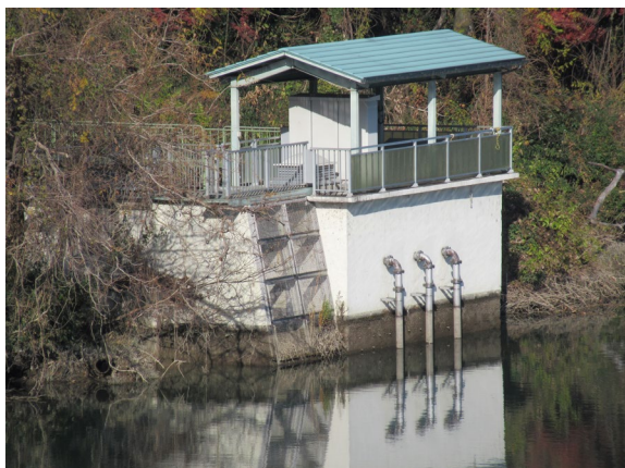
老朽化した森山浄水場の取水施設
