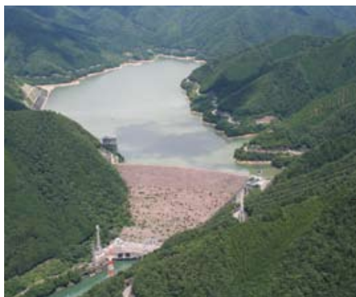
水源となる岩屋ダム 岐阜県下呂市金山町地内 昭和52年3月完成 有効貯水量/15,000㎡
