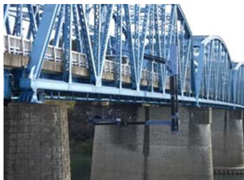
橋りょう点検車による点検状況
