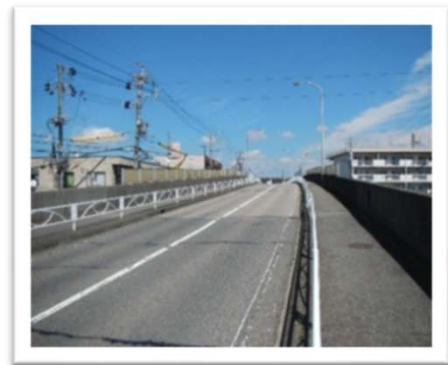
塚渡陸橋 橋長138.0m 架設年次1981年
