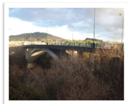
青柳大橋 橋長137.0m 架設年次1997年
