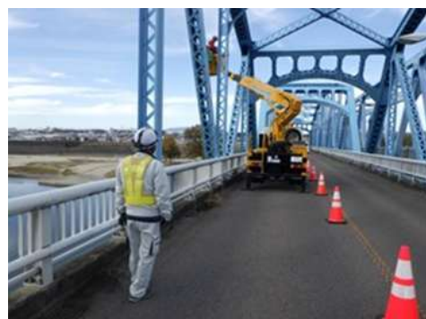
高所作業車による点検状況
