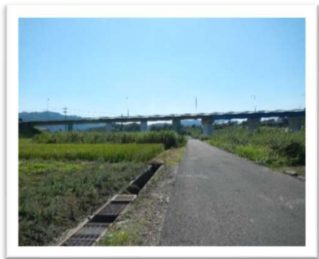
西町跨線橋 橋長166.0m 架設年次1967年
