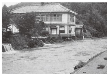
濁流で土台が流された当時の 三和連絡所（三和町川浦）
