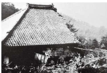
土砂災害により建物が半壊した 龍安寺（伊深町）
