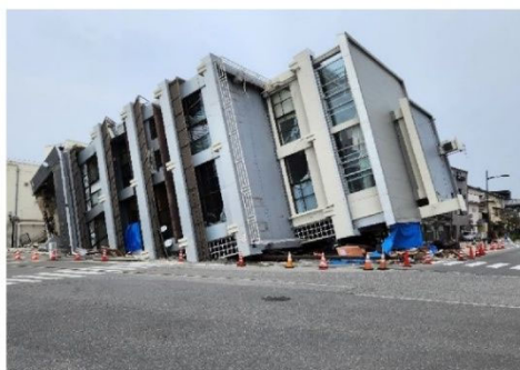
倒壊したビル
