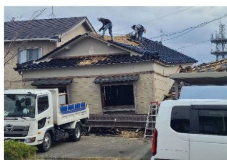
解体中の被災家屋
