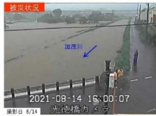
令和3年8月大雨の加茂川の溢水
