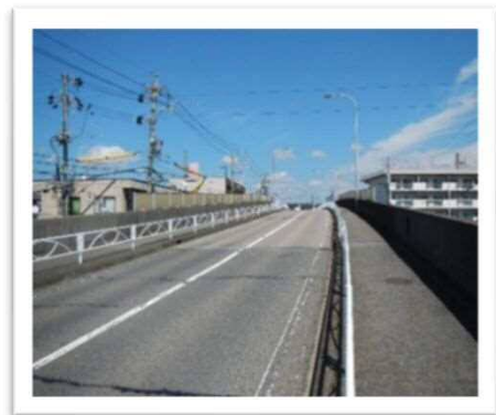
塚渡陸橋 橋長138.0m 架設年次1981年
