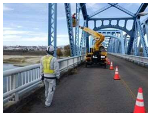
高所作業車による点検状況
