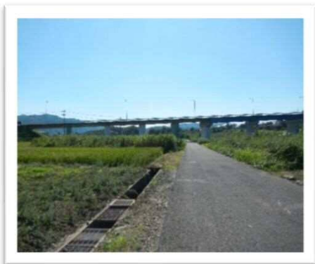
西町跨線橋 橋長166.0m 架設年次1967年
