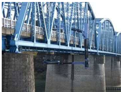
橋りょう点検車による点検状況
