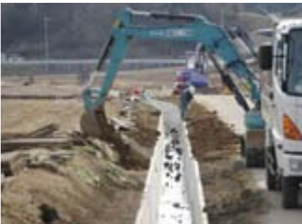
▲山之上町地内の排水施設を整備
