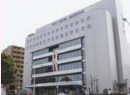
▲美濃加茂商業ビルの改修
