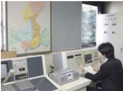
▲デジタル化に対応した操作卓に更新
