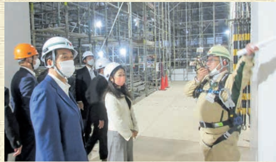
文化会館（改修工事現場の視察）
