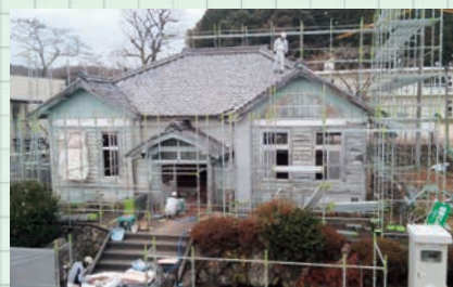
旧伊深村役場庁舎 改修の様子
