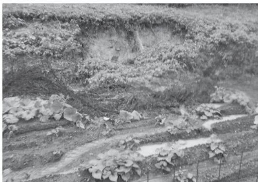
豪雨被害の様子
