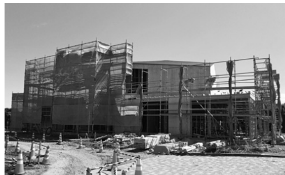
自然環境体験学習館の工事の様子
