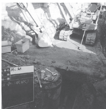
漏水箇所修繕工事の様子
