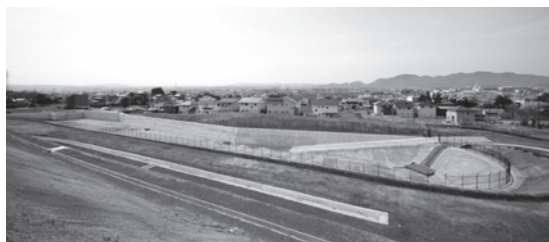
造成が完了した生物工学研究所跡地
