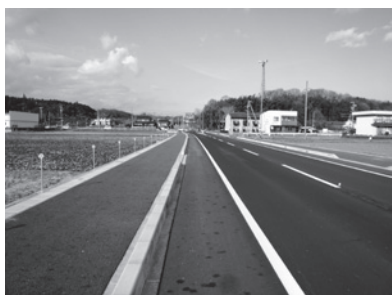
平成27年12月に開通した塚原河渡線の区間
