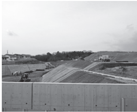
造成工事の様子(生物工学研究所跡地)
