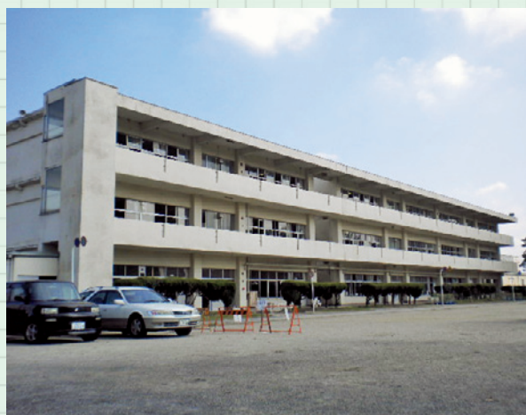
改修を待つ山手小学校校舎
