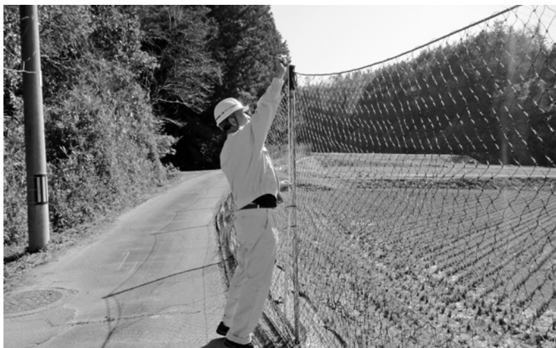
田んぼに設置されたネット柵(山之上町田畑地内)
