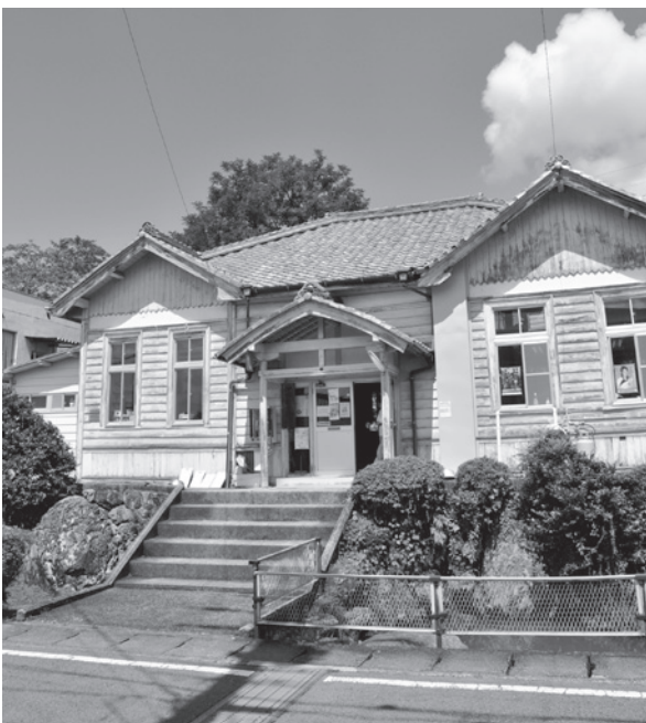
伊深自治会館(昭和11年竣工)
