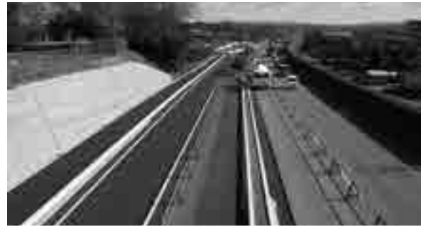
4車線化の整備が進む国道248号太田バイパス
