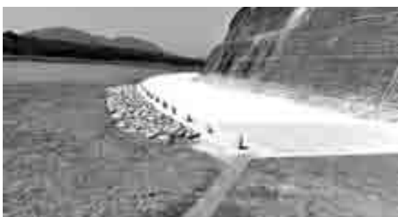
整備が進む低水路護岸
