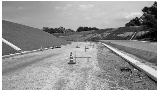
造成工事が進む中蜂屋工業団地
