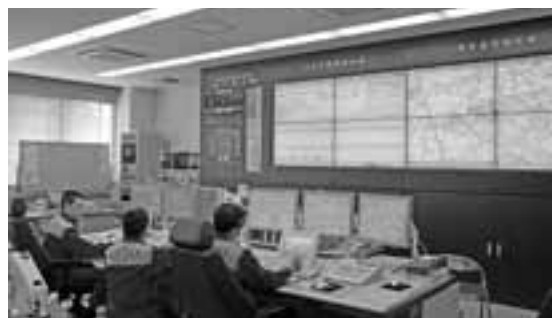
高機能消防司令システム
