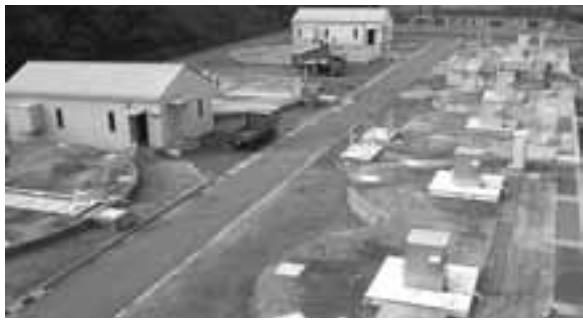
蜂屋川クリーンセンター
