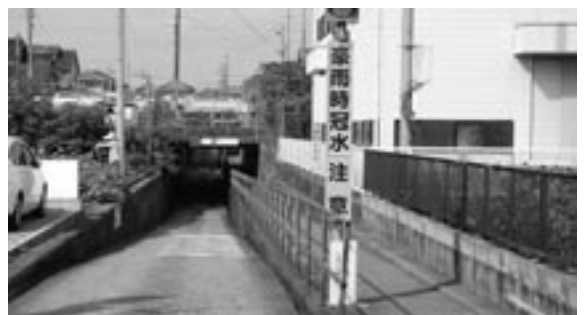
豪雨時の冠水に注意が必要な地下道
