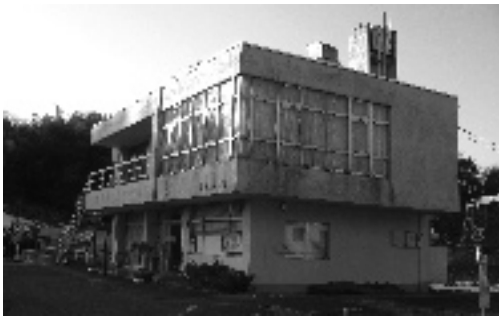
解体され駐車場として整備される山之上公民館
