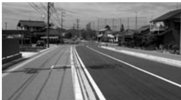
改良工事の進む市道神明森山線
