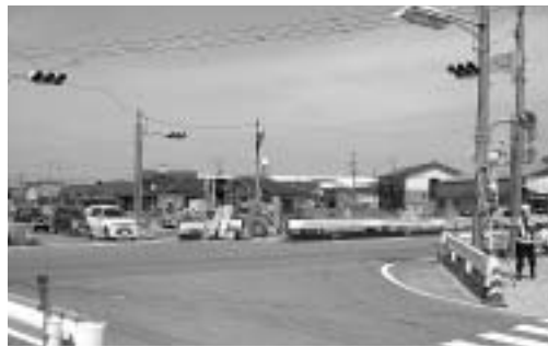
工事が進む「川合町1」交差点
