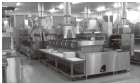
新給食センターの洗浄室
