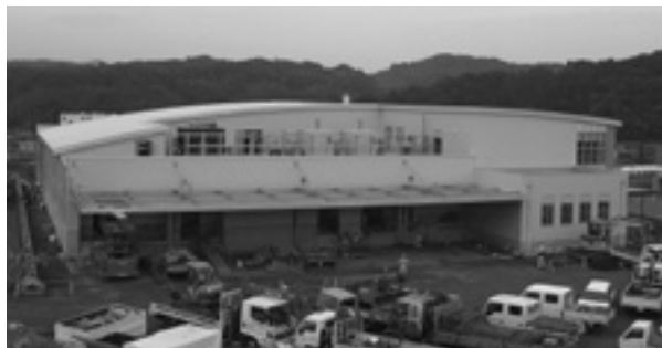
整備中の新給食センター
