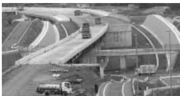
国道41号バイパス（山之上地内）
