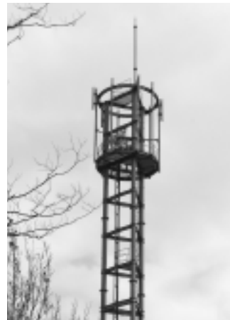
携帯電話の基地局(アンテナ)
