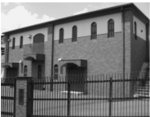
耐震化された森山配水池
