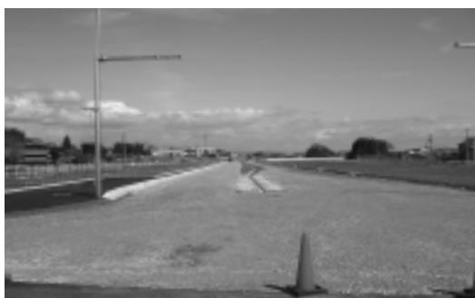
工事中の国道248号バイパス
