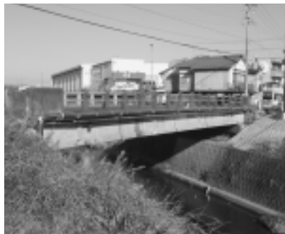
落下防止対策を講じている光徳橋
