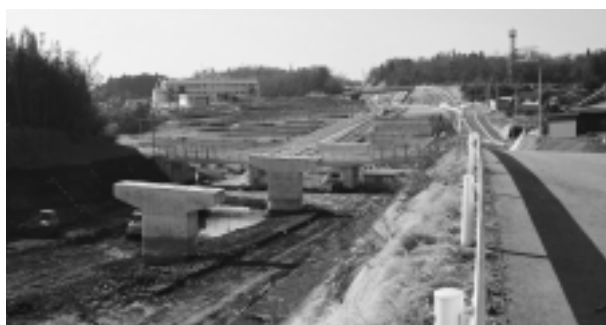
工事が進む国道41号バイパス
